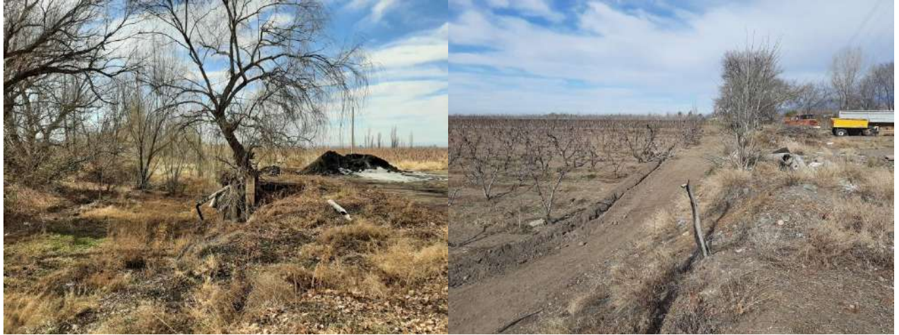
Fotografía N°5: Desnivel del relleno presente
