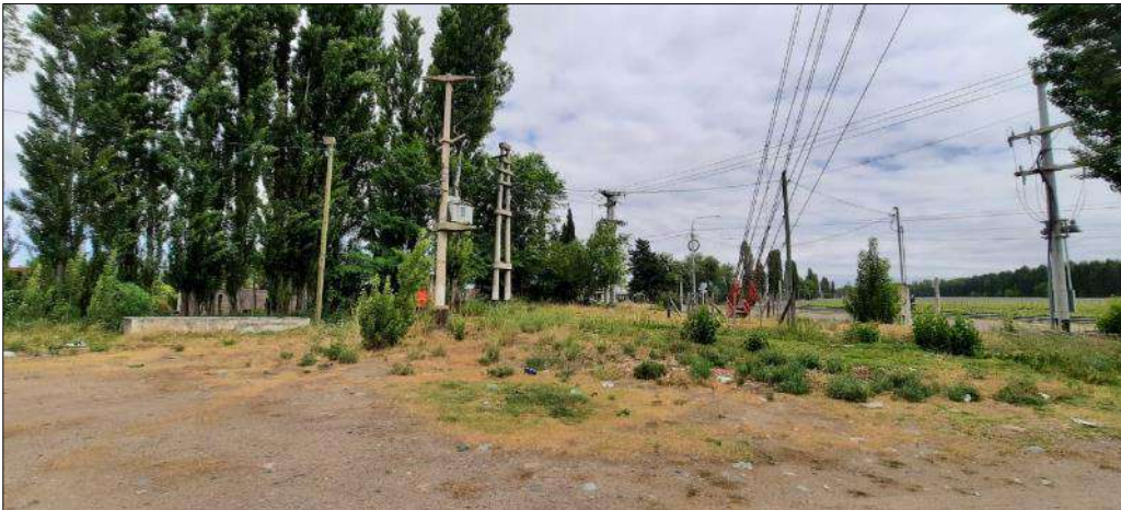
Figura 54: Tillas de anclaje y riendas de antena
