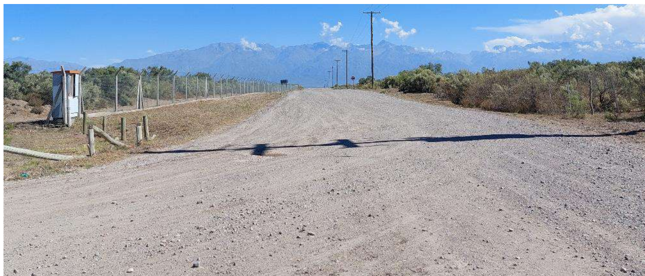
Figura 2: Vista general camino de acceso
