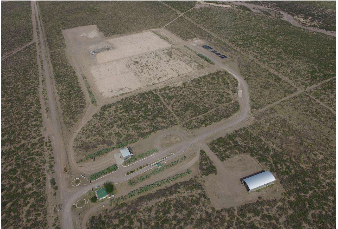
Figura 3: Vista área del predio CA-COINCE CÁPIZ
