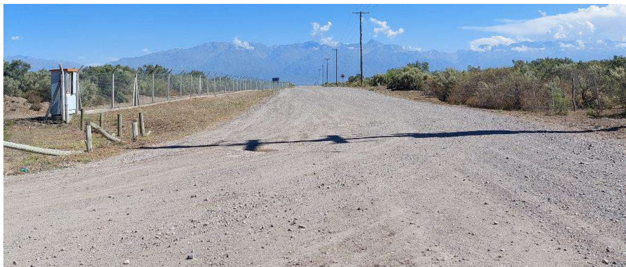
Figura 76: Vista general camino de acceso
