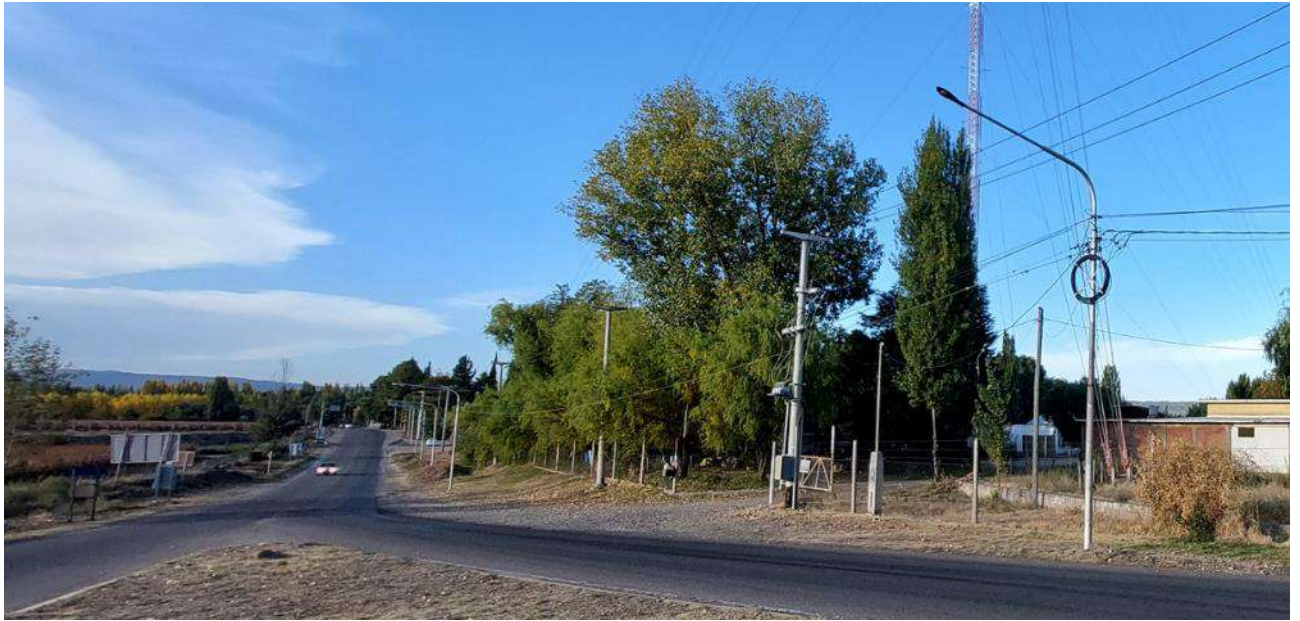
Figura 84: Vista general del predio CA-TP
