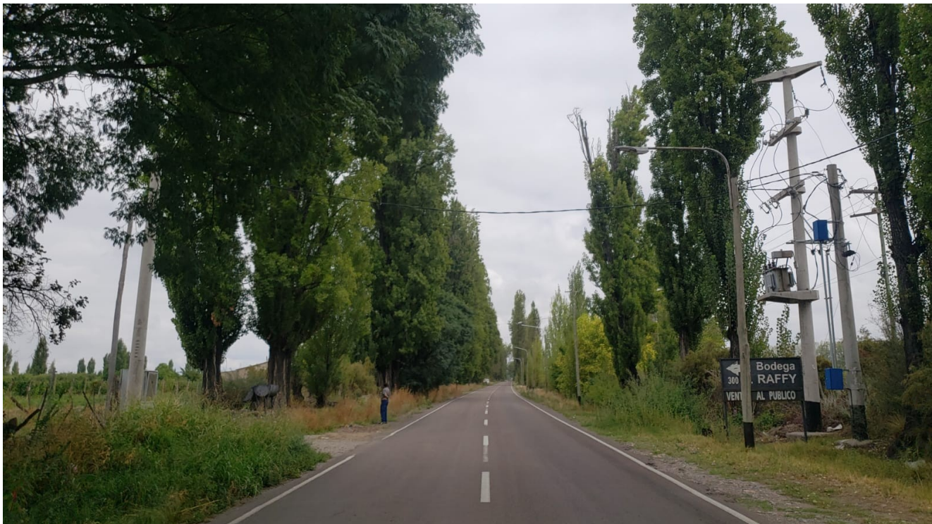
Foto 1: Fotografía tomada de Este a Oeste en calle La Vencedora, Distrito Gualtallary. Subestación CN 248 N.º T3897 .
