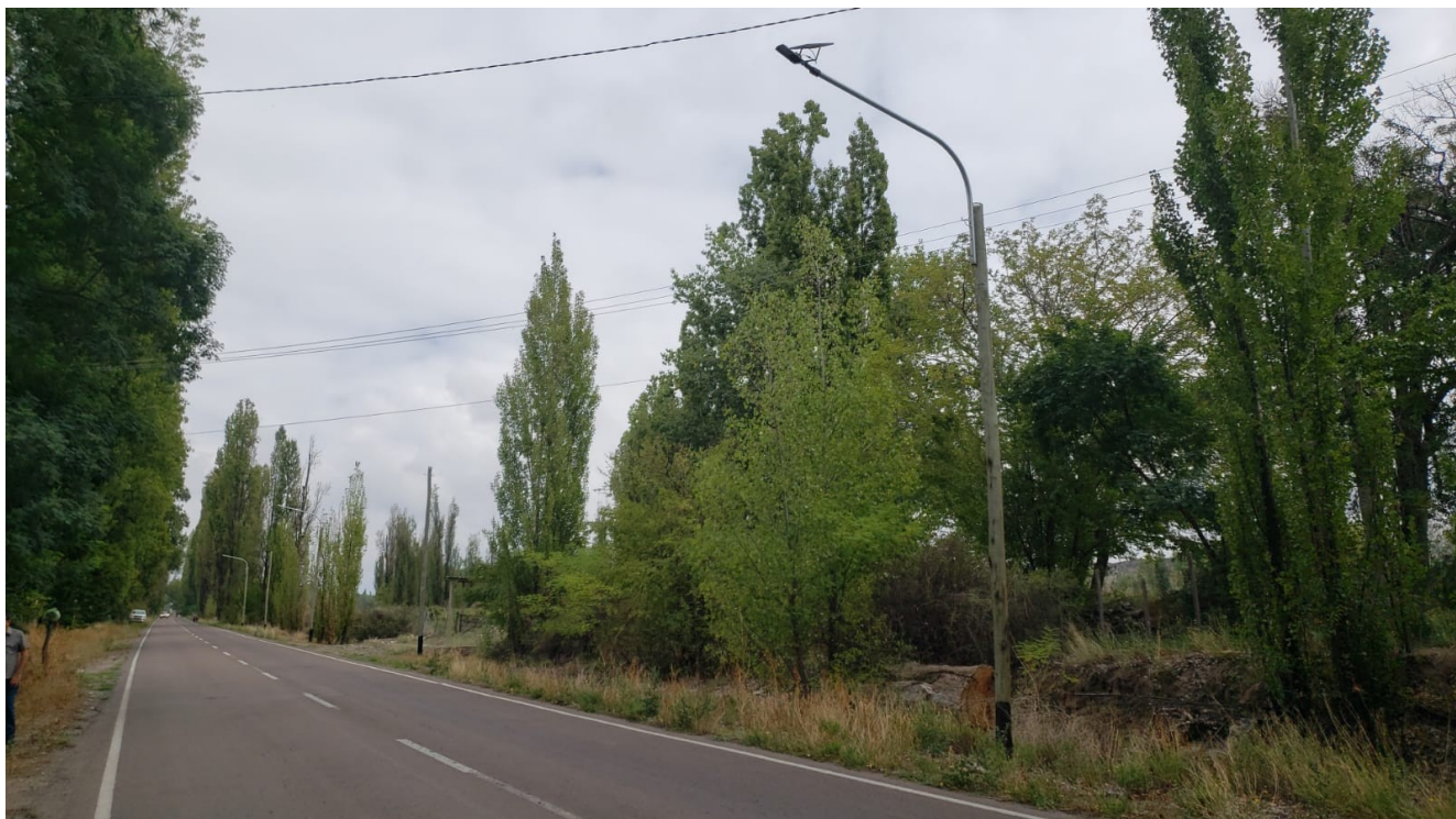
Foto 2: Fotografía tomada de Este a Oeste en calle La Vencedora, Distrito Gualtallary. Columnas soporte sin tendido de cables aéreos preensamblados.
